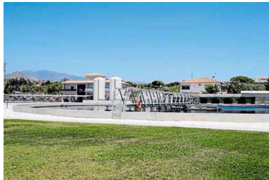
Otra vista de la planta de aguas residuales de Guadalmansa.sur
